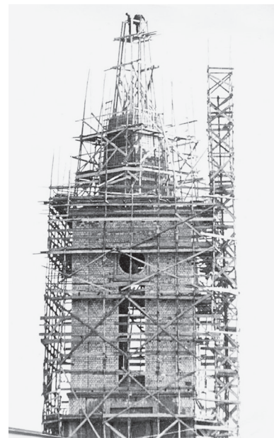
Bažnyčios bokšto viršūnės montavimo darbai 1981–1982 metais.
